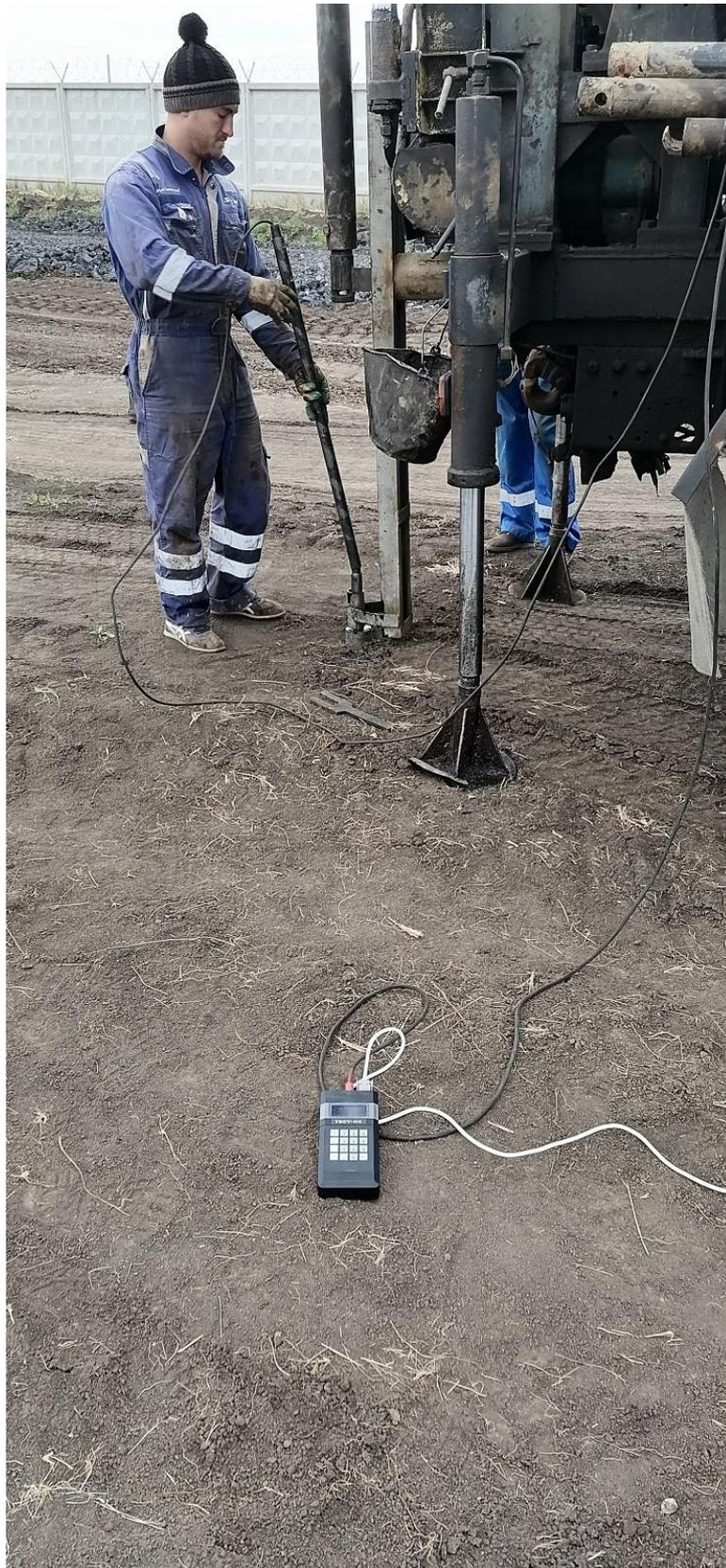
Рис.1.3 Статическое зондирование грунтов на площадке.
