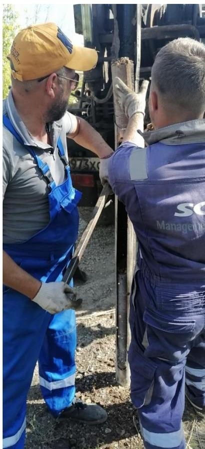
Рисунок 1.1 – Начало бурения установкой ПБУ-2 инженерно-геологической скважины
