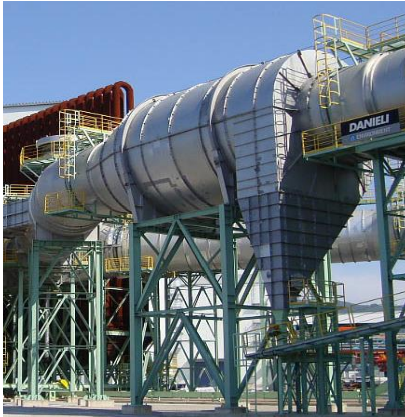
Рисунок 2.6.4 - Циклон
