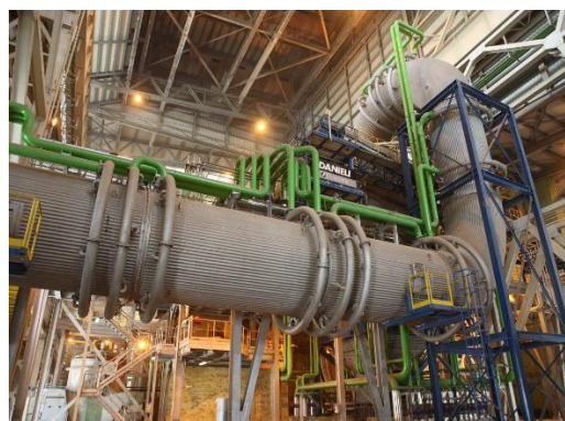
Рисунок 2.6.1 - Водоохлаждаемый газоход ДСП-130
